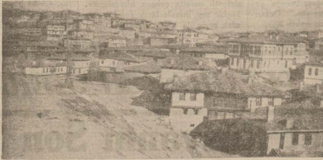
Ilgaz kasabasının umumi görünüşü
